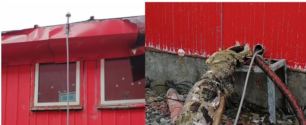
*Imagen 2. Antena GPS instalada en el techo de la Base Antigua, sujeta a la lata con abrazaderas y con salida desde el cuarto de tratamiento de agua junto con tuberías de aguas servidas.*
